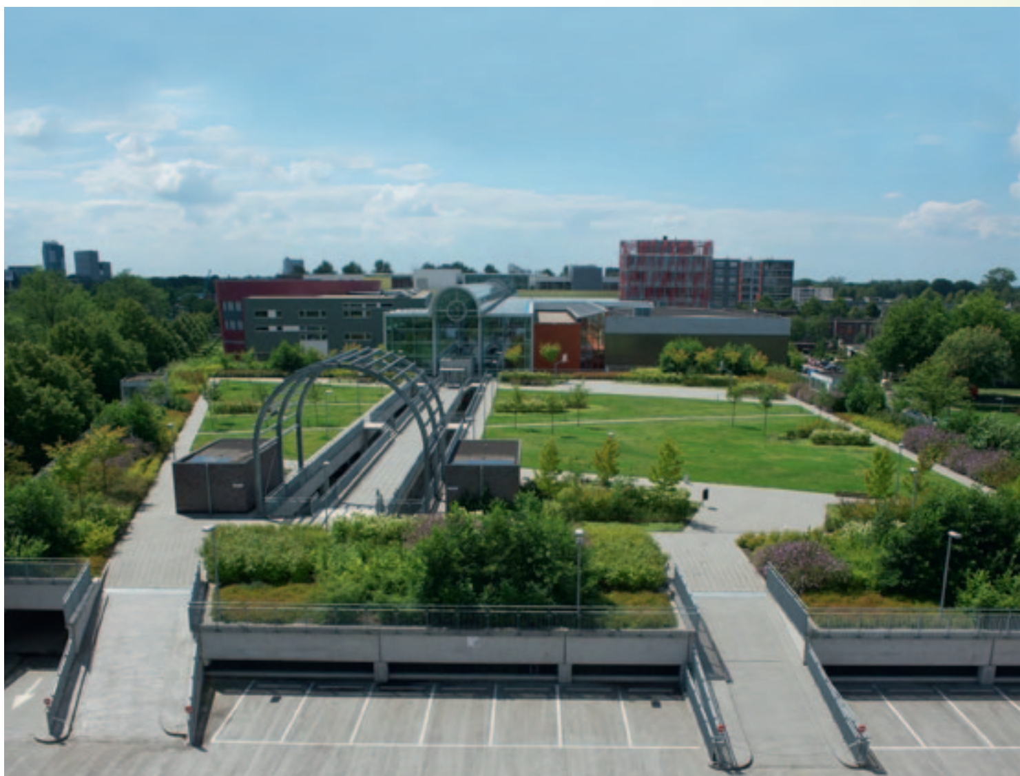
Een beloopbaar groendak beschermt de dakbedekking.
