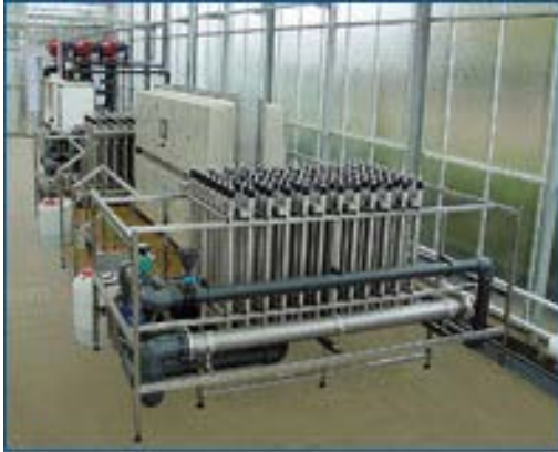
Afb. 3: Lage druk UV-ontsmetter gebruikt bij recirculatie bij de teelt van aardbeien onder glas.
