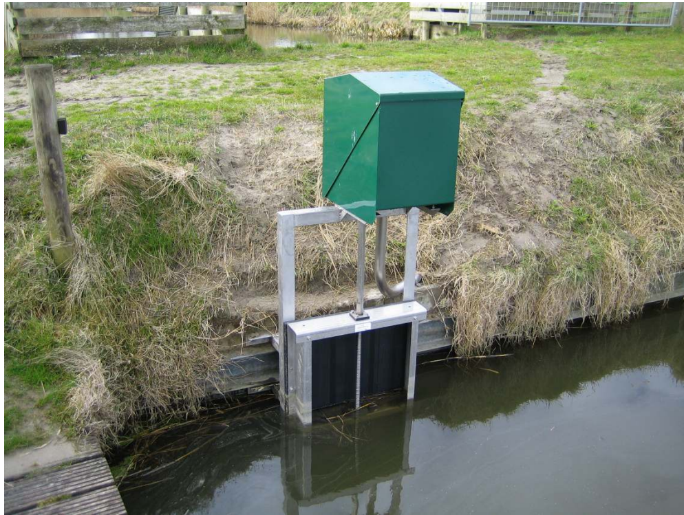
Automatische schuif die de grootte regelt van de inzwemopening bij de duiker aan de lage polderzijde, en daarmee de stroomsnelheid in de DeWitpassage bij Wier.
