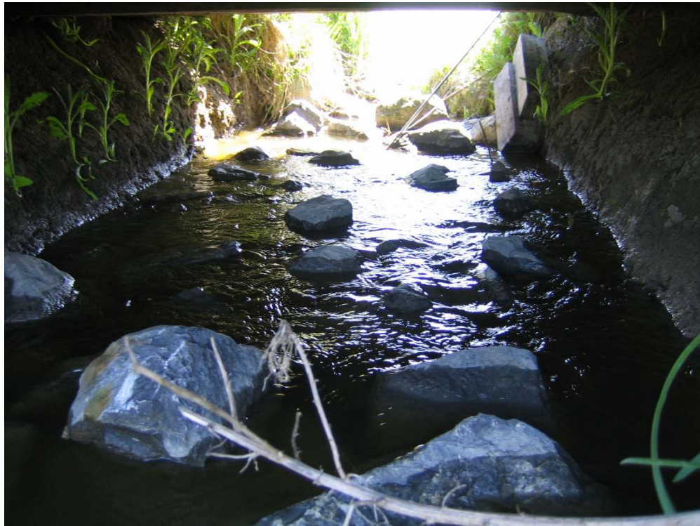
Vistrap van het polderwater van de Blikvaart naar het boezemwater van het Wierzijlterrak (foto A&W).
