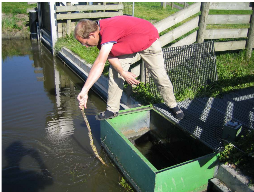
Handmatige verwijdering van vegetatie en rotzooi voor de instroom/uitzwemopening aan de boezemzijde van de DeWitpassage bij Wier.
