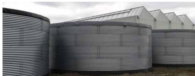
Silo's voor opslag hemelwater en testwater
