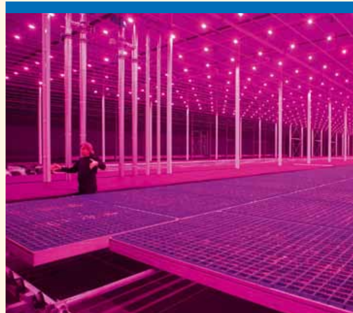
De nieuwe afdeling met LED-verlichting en een dubbelscherm met drie doeken (voor beperken lichtuitstoot, instraling en energieverbruik) heeft nu nog één teeltlaag, maar dat wordt in de toekomst een meerlagenteelt.
