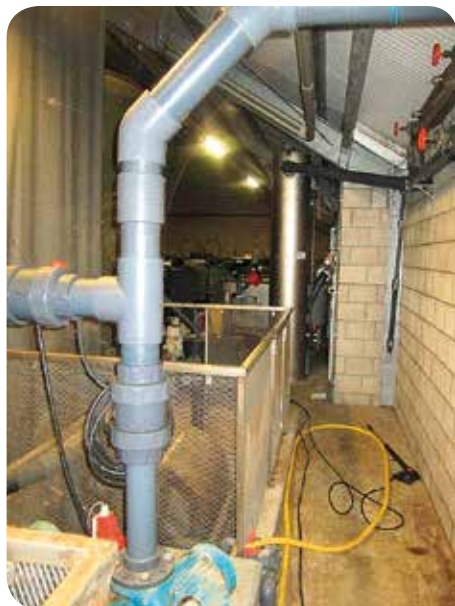
Een drumfilter in een lager gedeelte van de kwekerij staat beschermd met een rek om te voorkomen dat de kinderen hier naar beneden vallen. Achter: de zuurstofreactor
