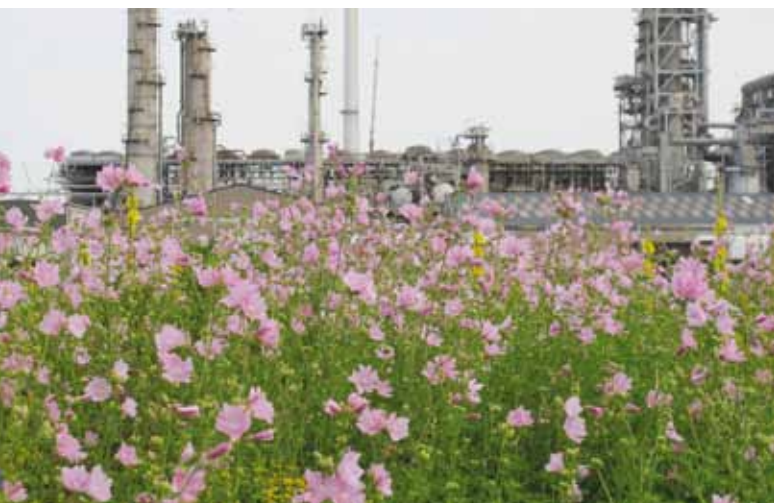
De petrochemische bedrijven kiezen bewust voor duurzame en ecologisch verantwoorde buitenruimte.
