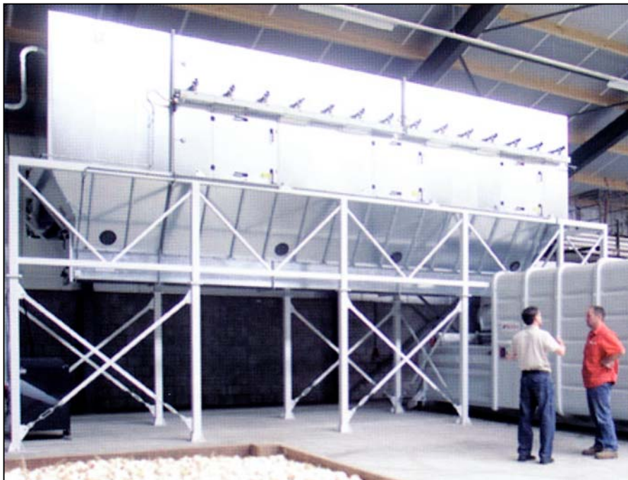
figuur 21: centrale afzuiger voor 100.000 m 3 /u
