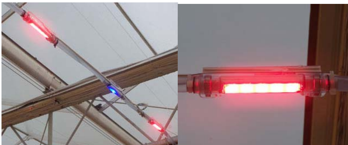
Figuur 3.5 Assimilatiebelichtingsysteem van Lemnis Lighting (met rode en blauwe lampen). Het systeem is watergekoeld. De rechter figuur toont een close-up van de rode lamp (Foto Lemnis Lighting)
