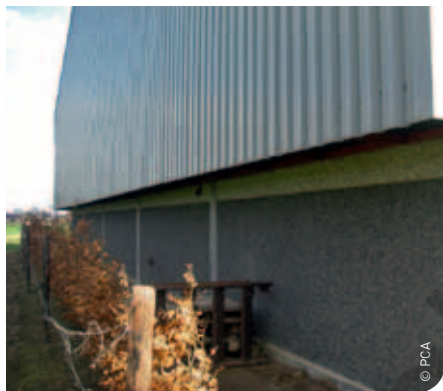
Een overstek die laag bij de grond komt, stuurt het geluid van de ventilatoren naar de grond, zodat het zich minder ver verspreidt.
