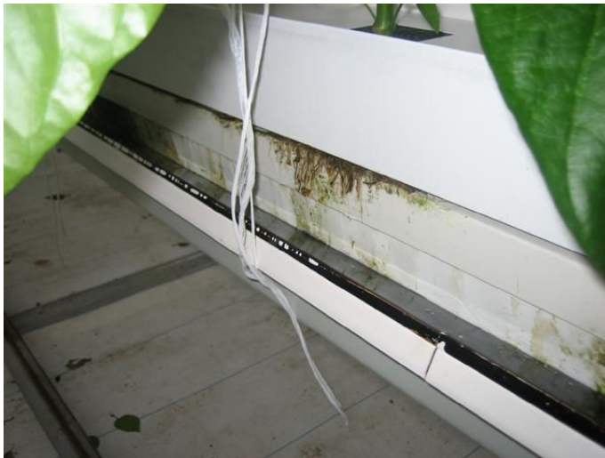
Foto 3. Kabelgootje op de drainafvoer gemonteerd
