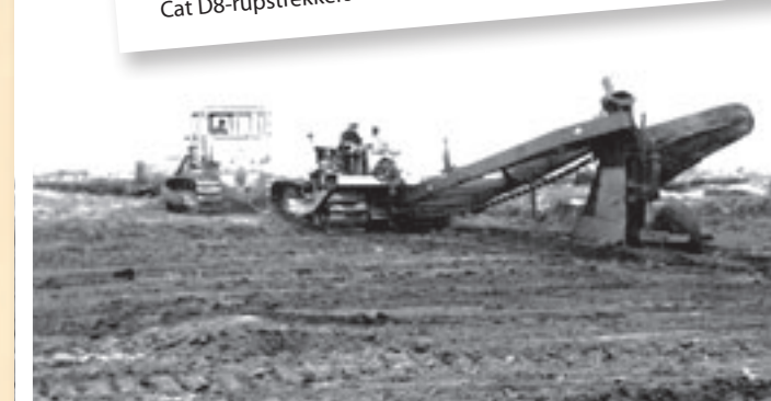
De aanbouwdiepploeg van KNHM achter een Cat D7 met verbrede rupsen. De werkdiepte (maximaal 150 cm) is regelbaar, afhankelijk van de dikte van de veenlaag en de hoeveelheid zand voor egalisatie. Het gevraagde trekvermogen varieert van 273 tot 492 pk.
