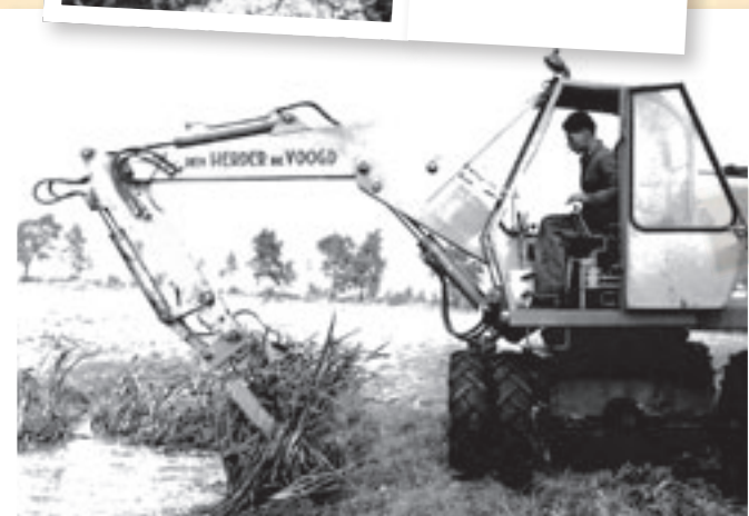
Met de 3 meter brede maaikorf van Gebr. Den Herder aan de arm van de Atlas 1200 hydraulische kraan worden beide taluds en de bodem van een watergang van 5 meter breed in een keer bewerkt. De chauffeur kan de korf met een hydraulische cilinder nauwkeurig aansturen.
