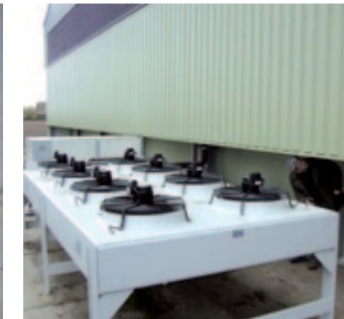
▲ Een overbemeten condensor met ventilatoren op laag toeren is stil.
