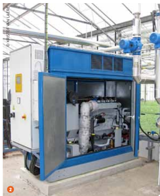
1 De micro-wkk van Rika en Patrick draait op koolzaadolie. 2 Bij Kristof Van Laere werd de wkk gedimensioneerd op het elektriciteitsverbruik. De installatie werkt op aardgas.
