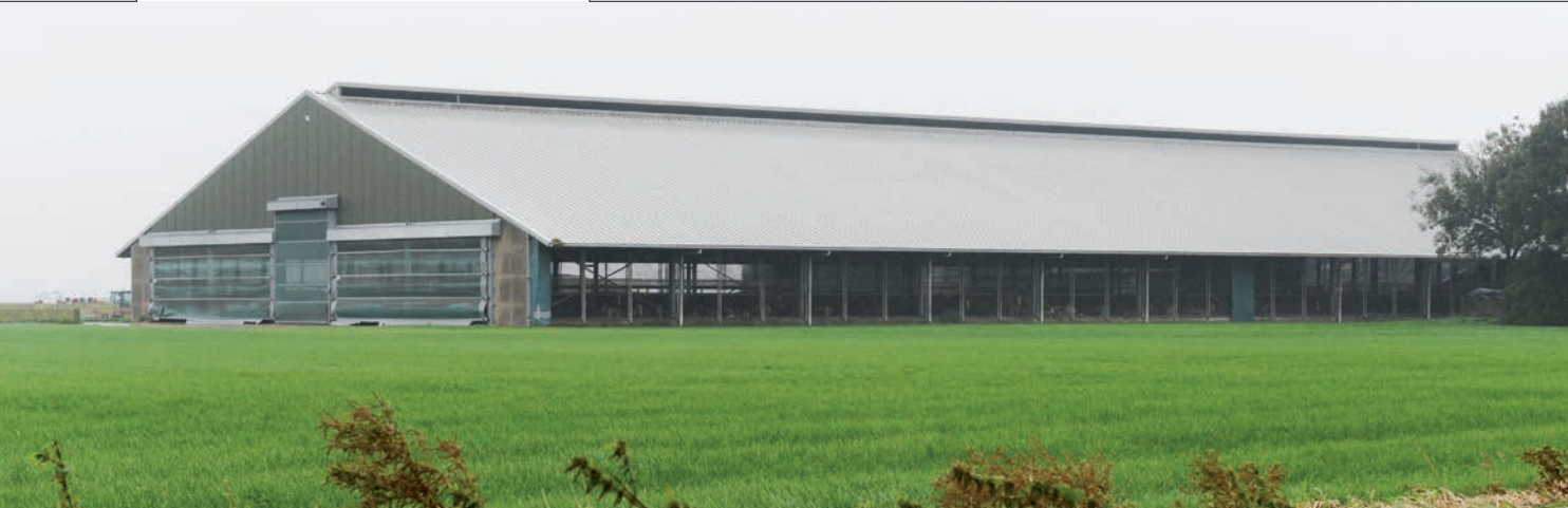
Het licht in de stal komt via de grote openingen in de zijwanden, er zitten geen lichtplaten in het staldak
