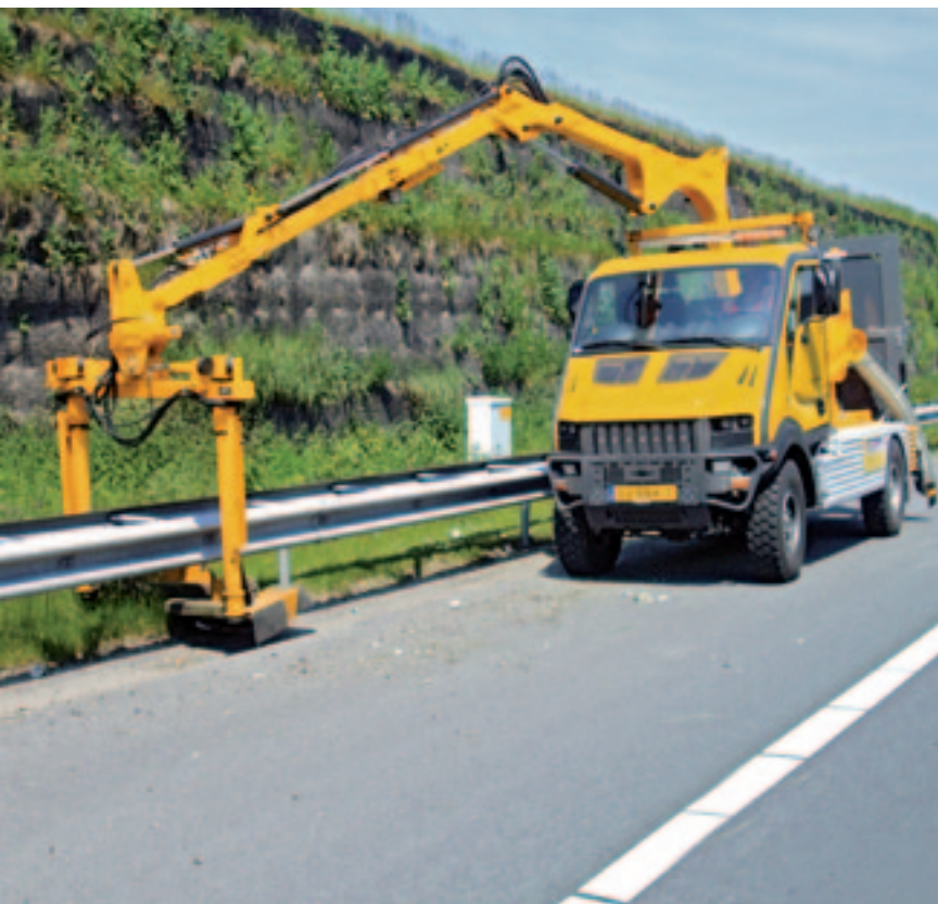
De Bremach uit Italië is maar 1,77 meter breed en kan daardoor op veel wegen 1,10 meter van de witte streep afblijven. En dan mag je werken zonder wegafzetting.
