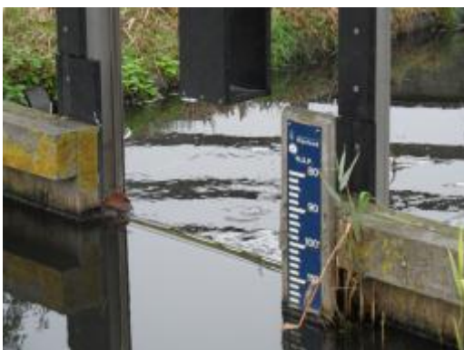
Figuur 22 het dammetje aan de Morsebellaan
