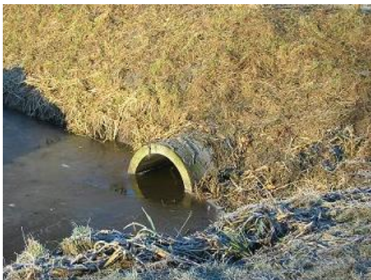
Figuur 24 dam met betonnen duiker
