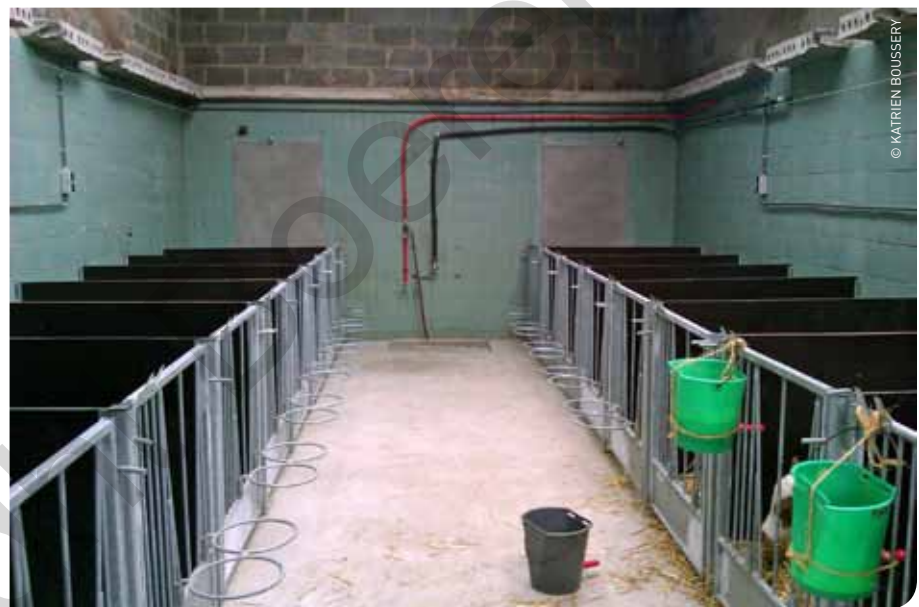
Om een goede luchtverdeling in de stal te verkrijgen en tocht te vermijden, is het van groot belang dat gaten in muren of spleten langs deuropeningen of plafond volledig dichtgemaakt worden.
