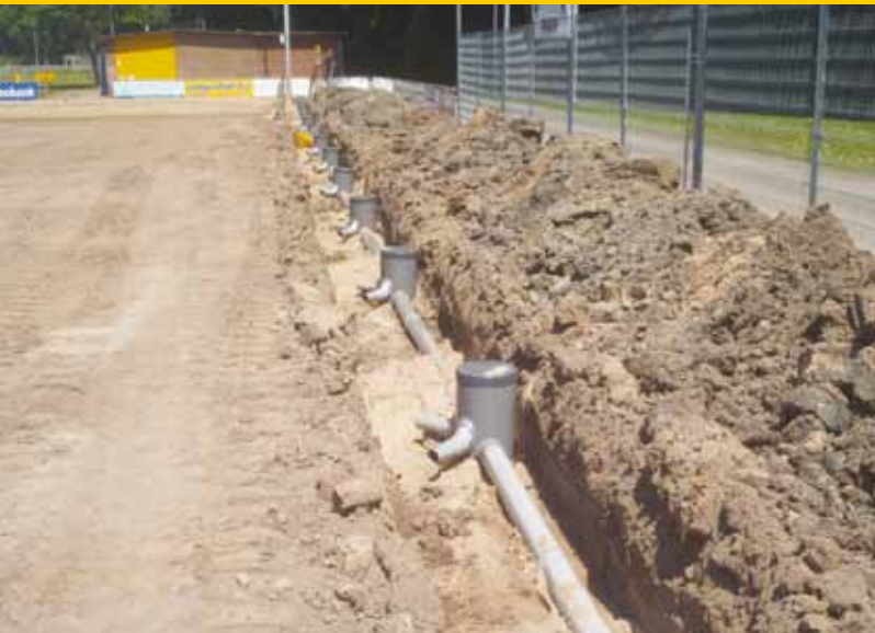
Aanleg van de hoofddrain.
