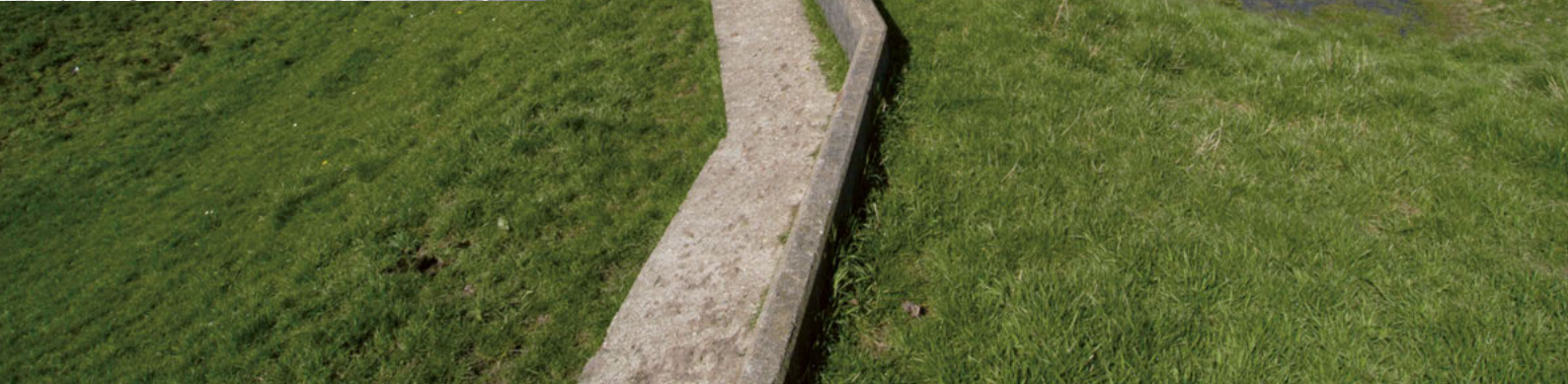
Muraltmuur op de Schenkeldijk bij Werkendam. Van 1906 tot 1939 werden in Zeeland tal van dijken versterkt met deze muurtjes. De meeste zijn intussen verwijderd.
