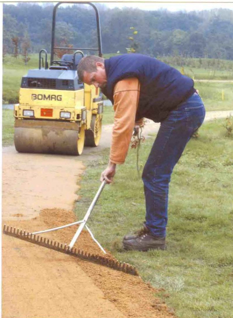
Altharcken - Nadat het pad is geroeid, worden de randen weggehaakt voor een hol eindresultaat.
