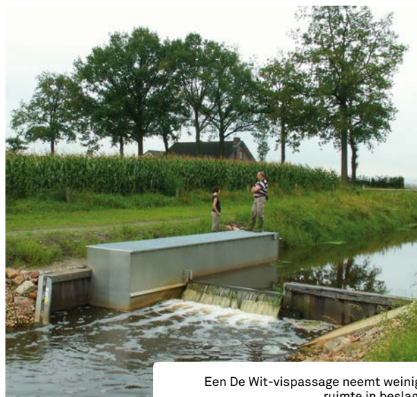
Een goed voorbeeld van een technische vispassage is de hevelpassage van Fishflow.
