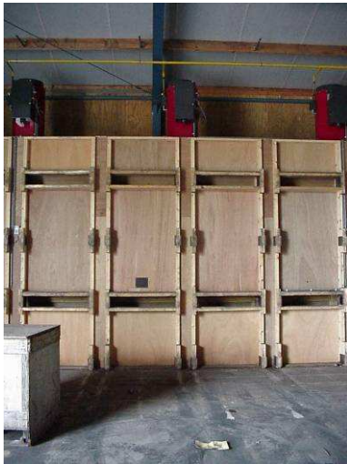
Figuur 1. Het dubbellaags bewaarsysteem voor kuubkistenbewaring. Foto: de buitenkant van het bewaarsysteem. De kisten worden voor de openingen geplaatst. De illustratie toont een schematische dwarsdoorsnede door het systeem met palletkisten en de luchtstroom. Illustratie: IMAG
