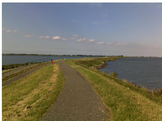
Figuur 8.3 Dijk Kinselmeer: aan twee kanten water
