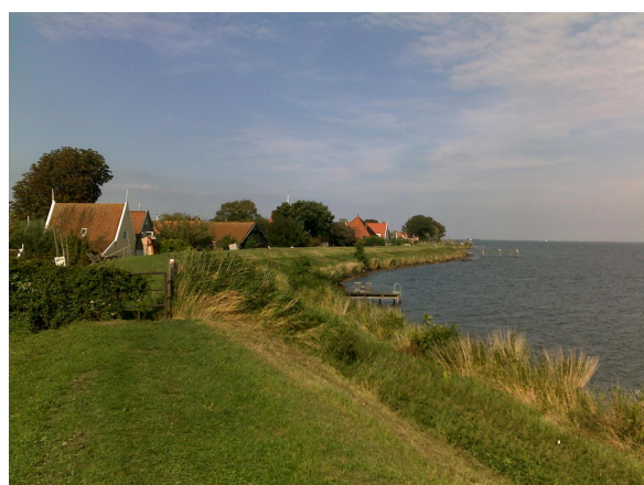
Figure 8.5 Uitdam: huizen vlak achter de dijk
