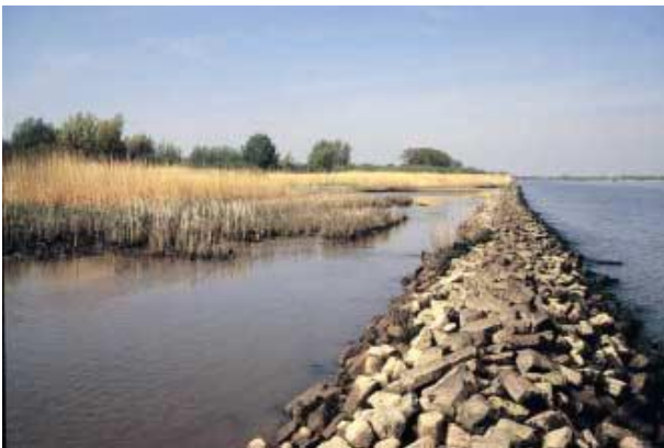
Figuur 2.1. Vooroeververdediging in de Oude Maas (waterlichaamcode NL94_4).
