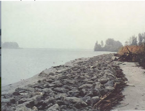
Figuur 2.4. Aanliggende vooroeververdediging van het Zuid-Maartensgat in de Brabantse Biesbosch (waterlichaamcode NL94_10) Bron: Boks (1998)
