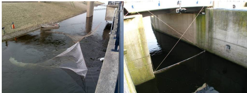
Figuur 22: Instromend zout water aan de zoete kant van de Krammerjachtensluis (boven) en fuikopstelling aan de zoete kant in doorgang Bergsediepsuis
