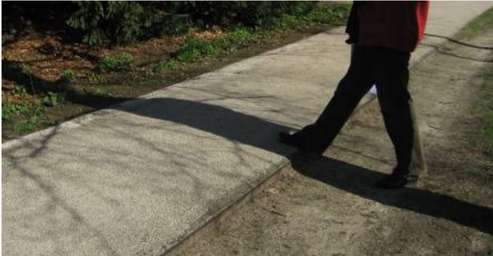
Afb. 41 Het verharde en met staalband afgezette pad steekt nu boven de grond uit
