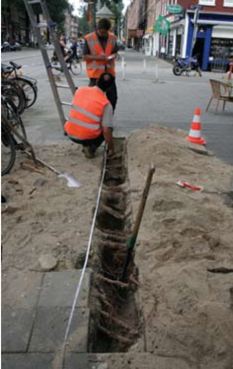
Het graven van profiel-sleuven geeft een goede indicatie van plaats, diepte en omvang van de beworteling.
