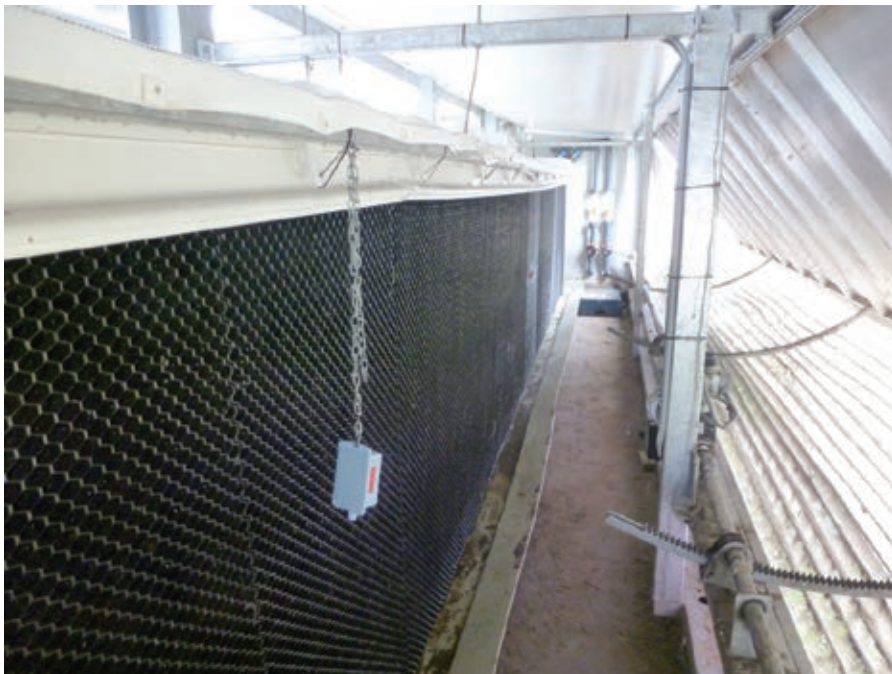
Figuur 1. Padwall in luchtbehandelingskast met draadloze sensor aan ketting.
