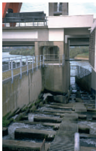
Foto 1: De oude 'Denil'-vispassage in de stuw bij Lixhe in de Maas (rechts). Deze vispassage bleekt slechts geschikt voor een beperkt aantal soorten. Daarnaast was het aanlokken-de werking gering omdat door deze vistrap weinig water stroomt. Inmiddels is een nieuwe vispassage volgens het model 'vertical slot' aangelegd (boven). (foto's Tom Buijse).
