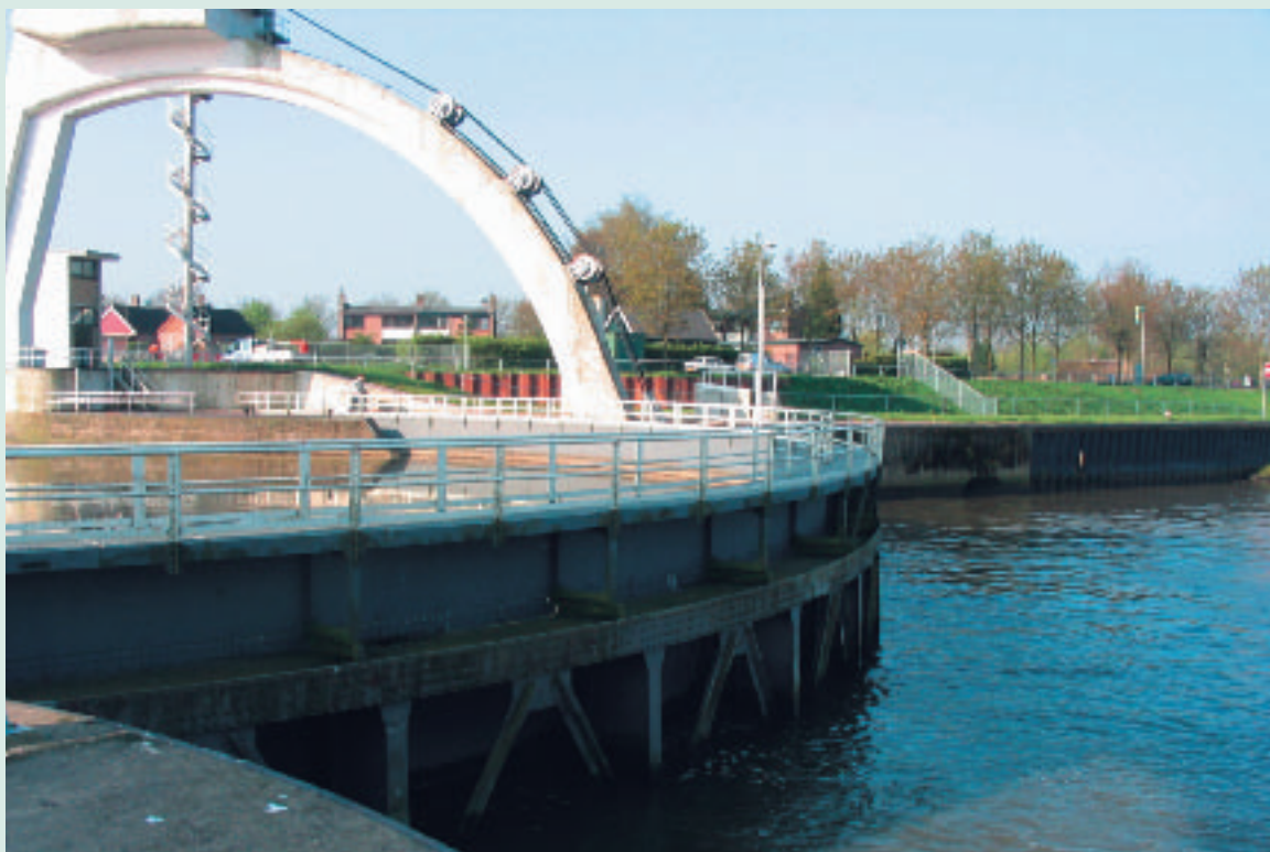
Op 22 april werd zoveel mogelijk water via de noordelijke vizierboog gespuid (boven). De zuidelijk boog was niet geheven (onder). (Foto's Tom Buijse)
