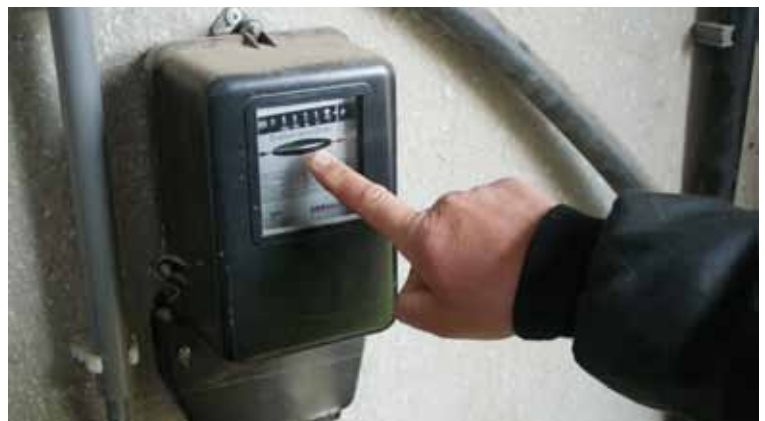
"Kijk, kijk... Dat is even wennen om te zien dat zo'n meter ook achteruit kan lopen. Van mij mag de zon blijven schijnen..."
