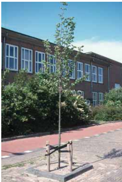
51. Een boomspiegel met rand houdt water met strooizout weg bij de straatboom.
