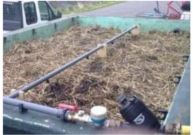
Foto 18: vóór de leiding met sproeidoppen, zijn een filter (zwart) en watermeter gemonteerd
