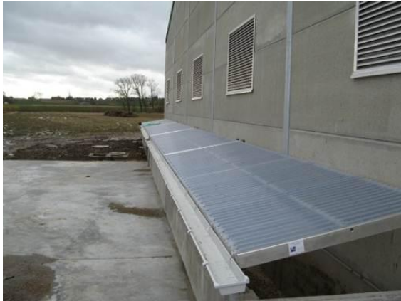
Foto 13 en 14: Fytobac, beton, gedraineerd, gevuld met Biomix: Een drainageslang voert overtollig water terug naar de vuilwateropslag (locatie: akkerbouw- en groenteteeltbedrijf Vlaanderen (foto's en ontwerp: Inagro vzw).
