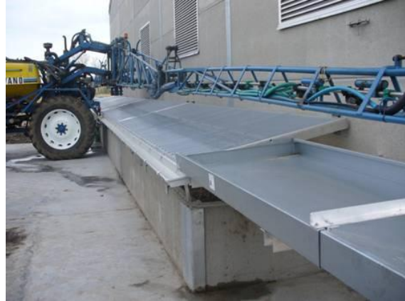
Foto 13 en 14: Fytobac, beton, gedraineerd, gevuld met Biomix: Een drainageslang voert overtollig water terug naar de vuilwateropslag (locatie: akkerbouw- en groenteteeltbedrijf Vlaanderen (foto's en ontwerp: Inagro vzw).
