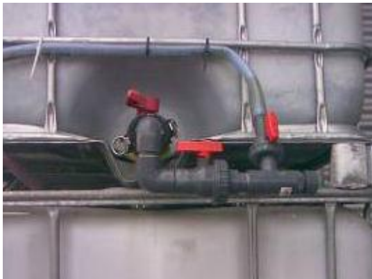
Foto 23: De afvoerleiding moet eerst 20 cm omhoog gevoerd worden en gaat dan naar de bak er onder.
