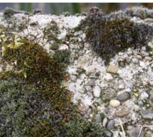
Figuur 2a Verweerd betonoppervlak gekoloniseerd door mossen, een veel voorkomend lokaal verschijnsel op oudere betonconstructies. Door het verweerde oppervlak worden vocht en bodemstofdeeltjes langer vastgehouden door het beton, waardoor een voedingsbodem gecreëerd wordt voor vegetatie.
