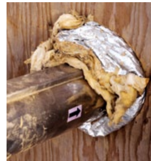
▲ Om te voorkomen dat het middel tijdens het gassen naar buiten stroomt, gebruikt Bob Doevendans van Profyto-dsd isolatiemateriaal.
