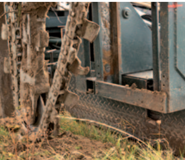
Een freesketting graaft de sleuf waarin de wortelweringswand wordt geplaatst.
