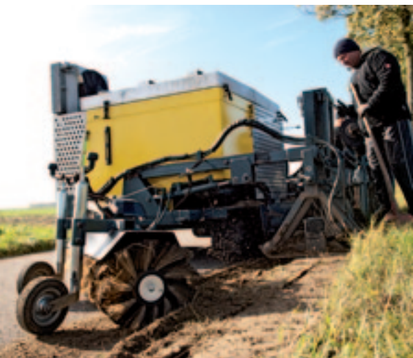
Een horizontale trilplaat verdicht ook het bovenste laagje van de grond in de sleuf. Een bezem veegt de weg schoon.
