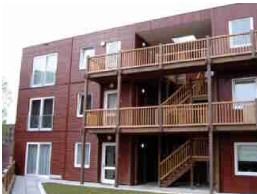
Figuur 6: Appartementencomplex Casa Vita in Deventer, waar 38 houtskeletbouwappartementen met vacuümtoiletten zijn uitgerust (Foto: Paul Telkamp).
