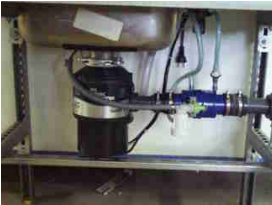
Figuur 7: Voedselrestenvermaler met aansluiting op een vacuümrioleringsysteem (Foto's: homesandbargains.co.uk en plumberscrib.com).
