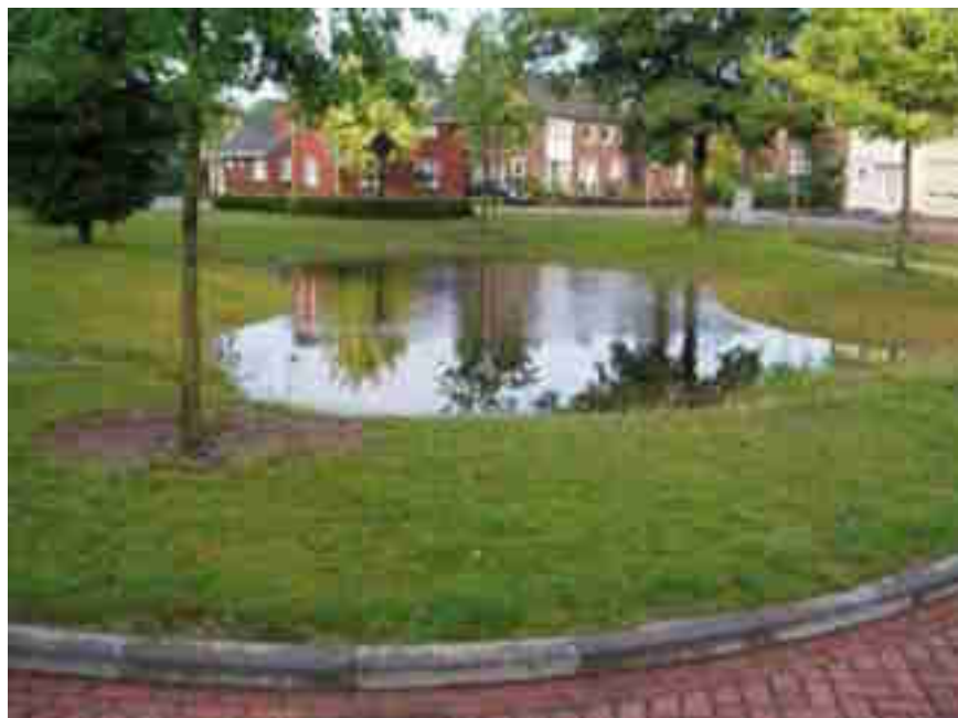
Figuur 14: Hemelwaterafkoppelmaatregelen. Boven een wadi voor hemelwaterinfiltratie. Onder een begroeid dak voor gedeeltelijke verdamping en een geleidelijkere afvoer van het resterende hemelwater naar een infiltratievoorziening.
