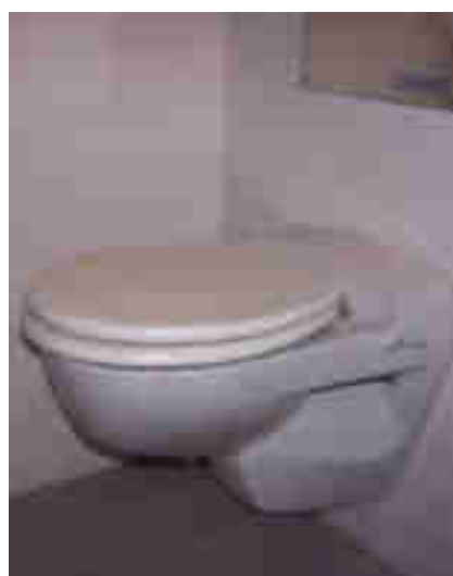
Figuur 5: Boven- en zijaanzicht van een vacuümtoilet (Foto: Erwin Koetse).
