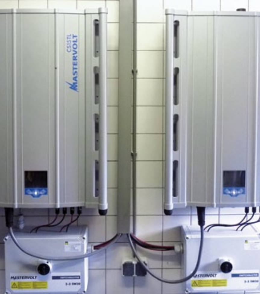
Het rendement van een omvormer varieert in de praktijk meer dan 10 procent.
