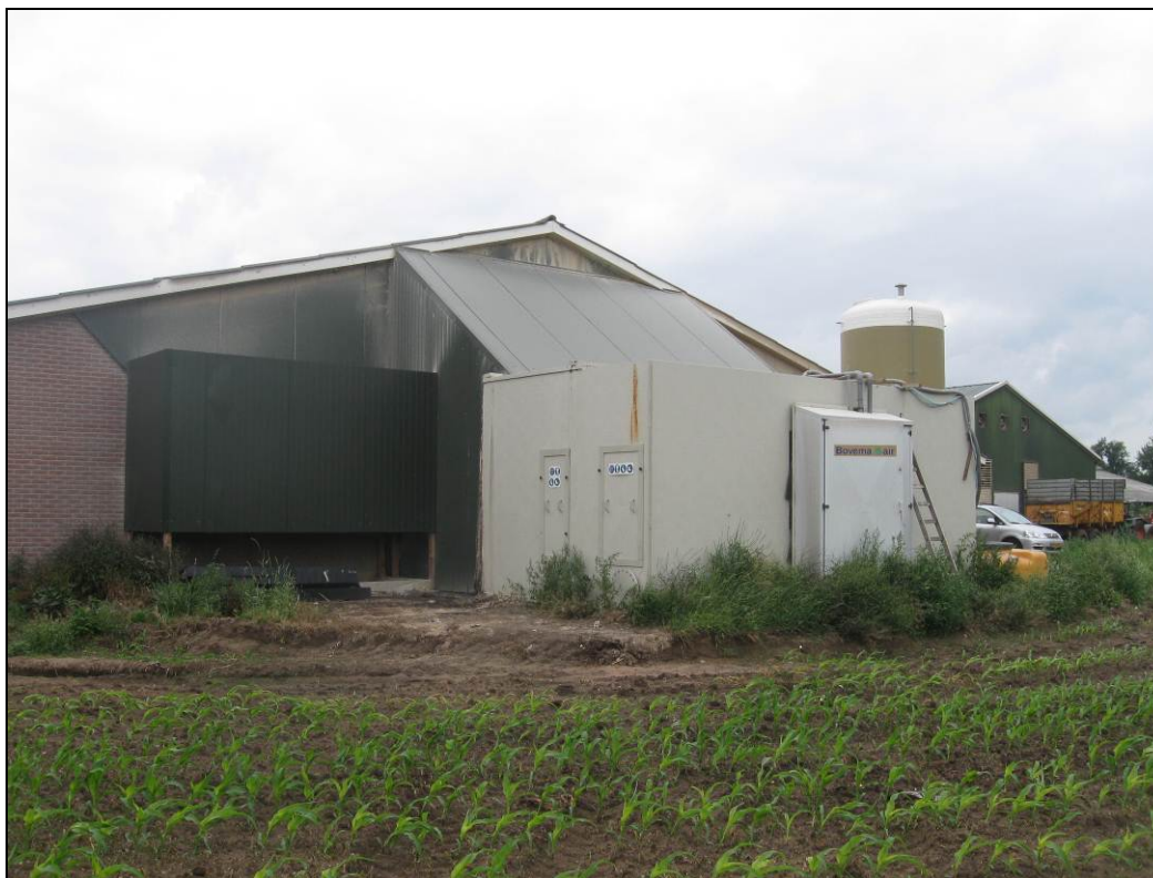
Opfokleghennenstal met chemische wasser
