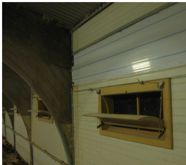
Luchtinlaat (binnenzijde stal)
