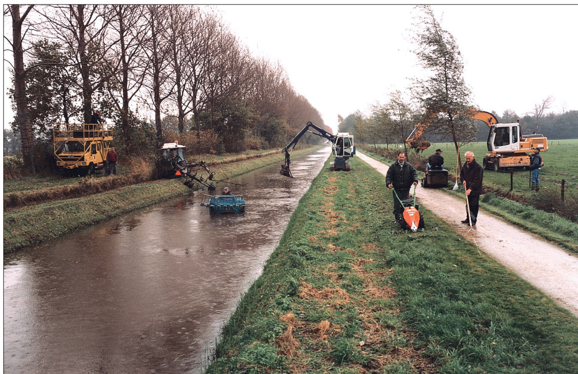
Figuur 1.5 Landschapsbeheer langs de Baakse Beek bij Zieunvent. V.l.n.r.: hoogwerker van de gemeente met twee medewerkers die de houtsingel opsnoeien; taludmaaier, boot met onderwatermaaier, en kraan op het maaisel op de kant te brengen van het waterschap; maaier met maaibalk op het ruiterpad van het recreatieschap; onderhoud door twee vrijwilligers van de Stichting Kerkepaden; loonwerker met maaikorf voor het slootonderhoud; de boer wiens voorouders hier vroeger zelf het beheer ter hand namen, kijkt toe.
