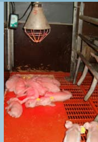
Een dimmer (links van de lamp) maakt het mogelijk om via een vooraf ingestelde curve de brandintensiteit van de biggenlamp geleidelijk te verminderen.
