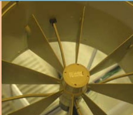
Kies voor zo groot mogelijke meetsmooit units. Als ze nog net terug te regelen zijn tot de minimum ventilatiebehoefte van een afdeling is het goed.
