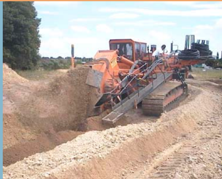
Bij voldoende oppervlakte rond de stal is aanleg van een horizontale bodemwarmtewisselaar in de vorm van kilometers slang die in de grond verdwijnen, een veel toegepaste aanpak.
