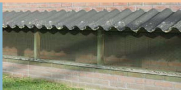
Ondergrondse luchtinlaat spaart energie en draagt bij aan een stabiel stalklimaat.
