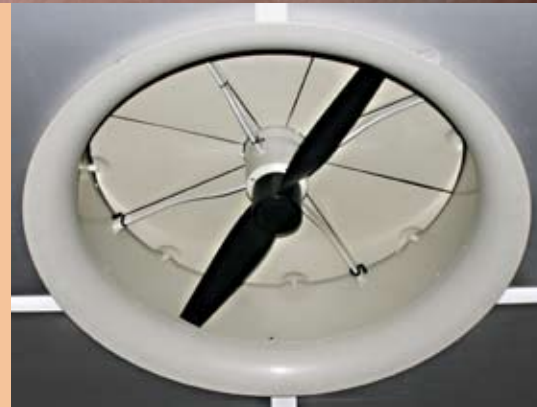
Schoon houden van de meetwaaier draagt bij aan de nauwkeurigheid van de ventilatie.
