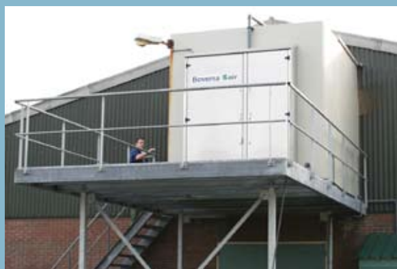
Een luchtwasser is een doeltreffende maar dure techniek om aan de emissie-eisen te voldoen.
