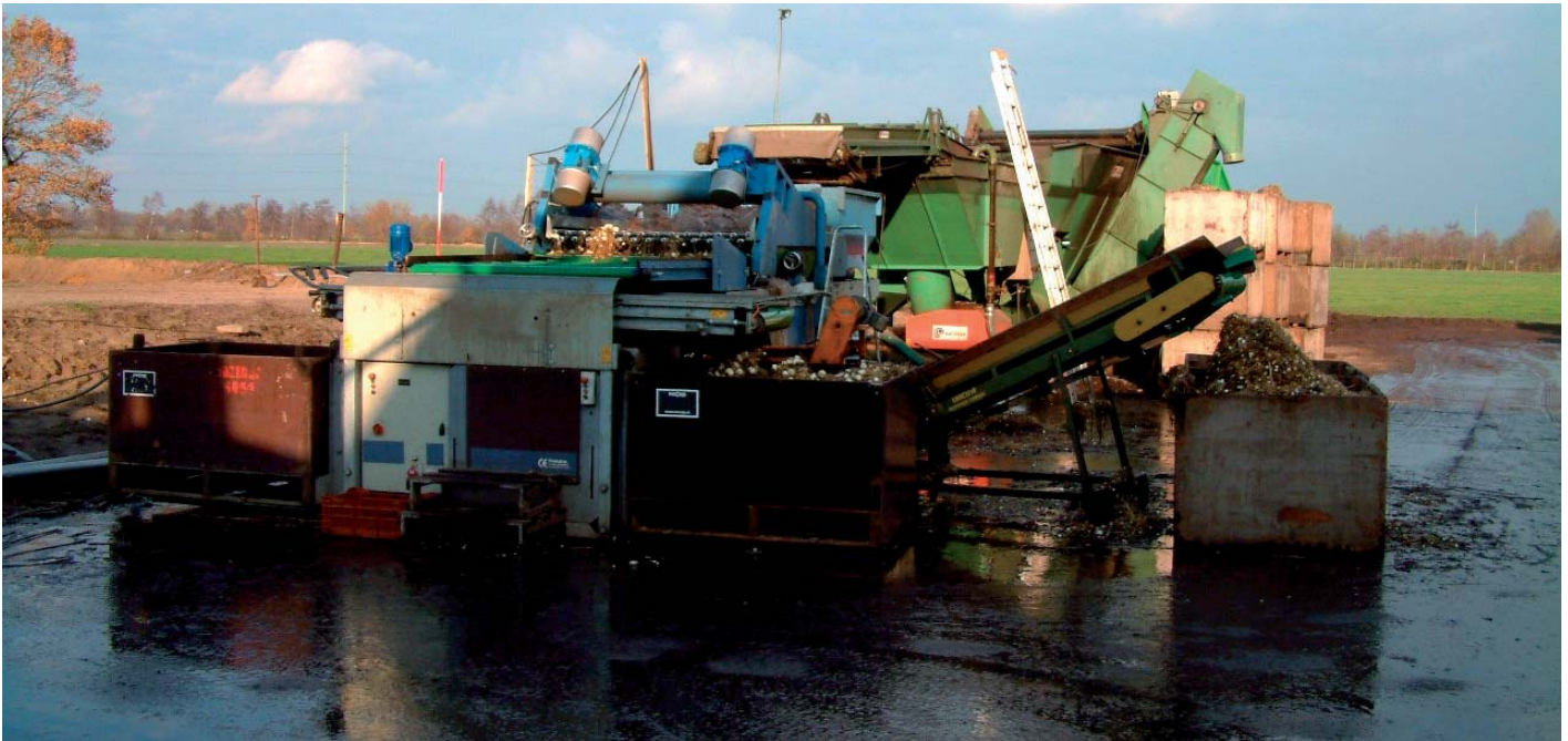
Ook de spoelwerkzaamheden op het bedrijf zijn aan regels gebonden
