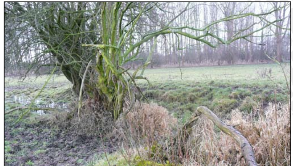
Boven: Het bakstenen sluisje (5a). Onder: Beschadiging van oude meidoornheg door vee (5b).
