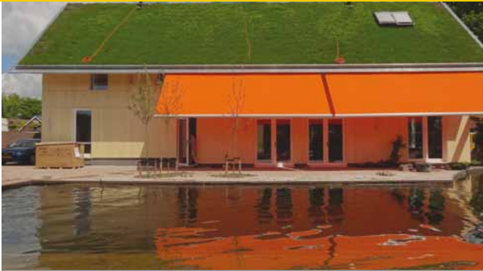
De demowoning van Bouwpuur in Roosendaal is dit voorjaar gedekt met Dakturf
