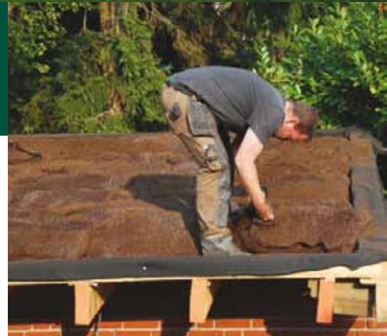
Installeren van een dak: gewoon zakken neerleggen en klaar
