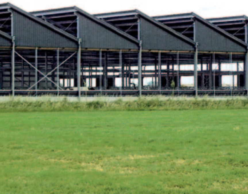
De familie Van der Steen bouwde een dak met een zaagtandconstructie.
