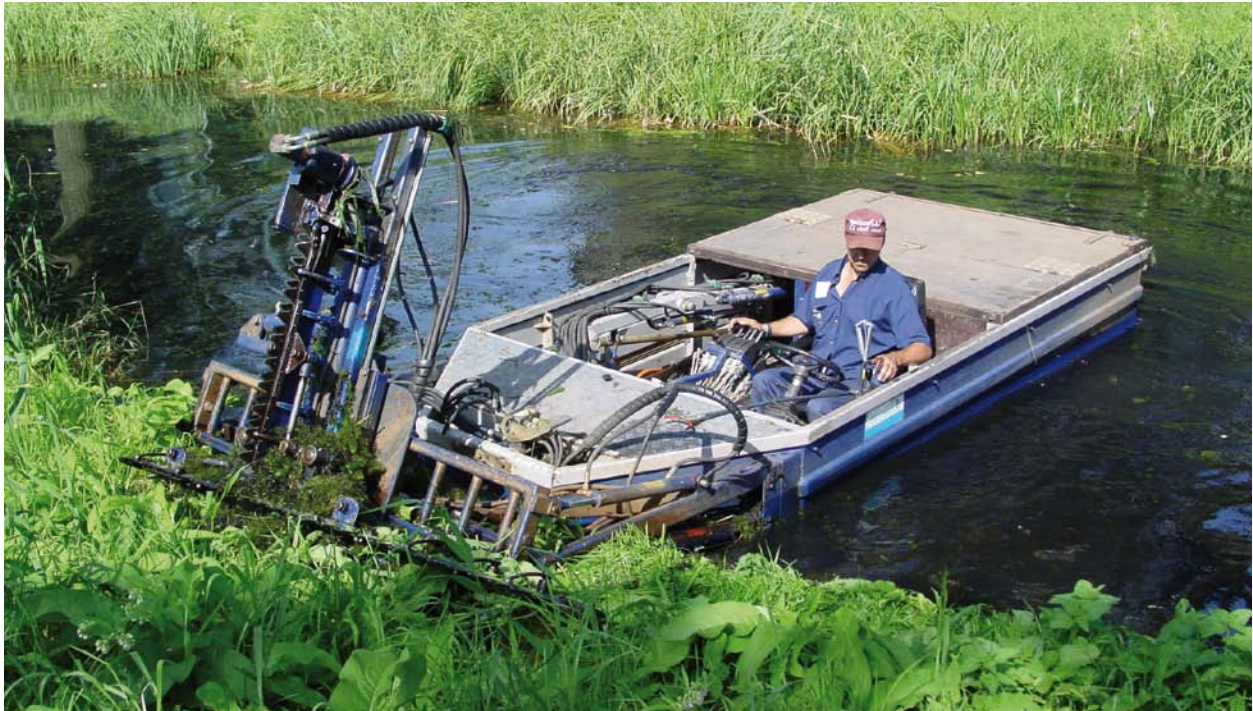
Tijdens onderhoudswerkzaamheden wordt zoveel mogelijk gewerkt volgens de gedragscode.
