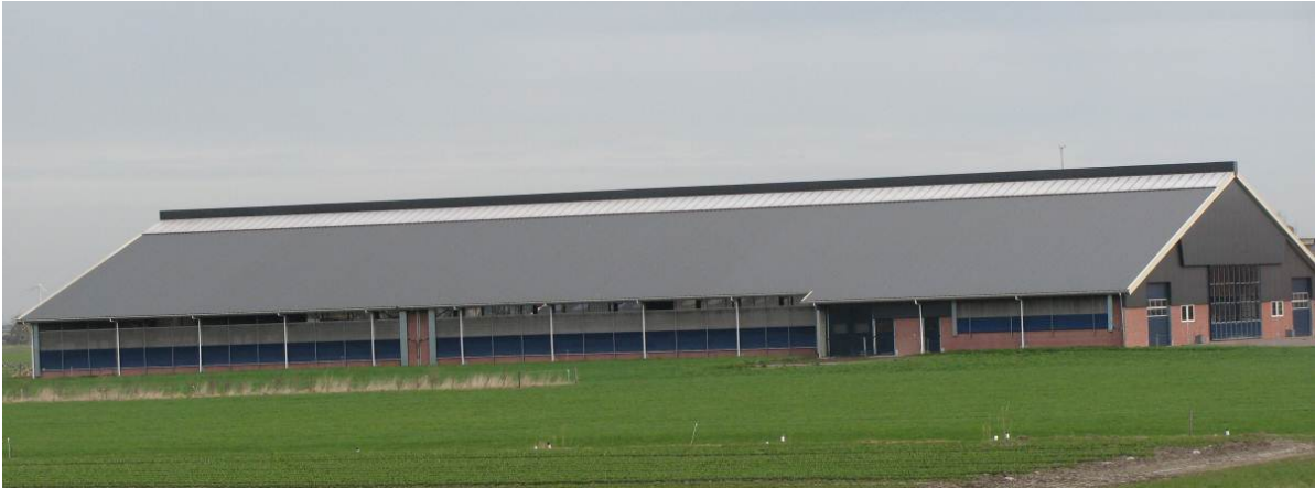
Figuur 1 Buitenkant van de stal.
